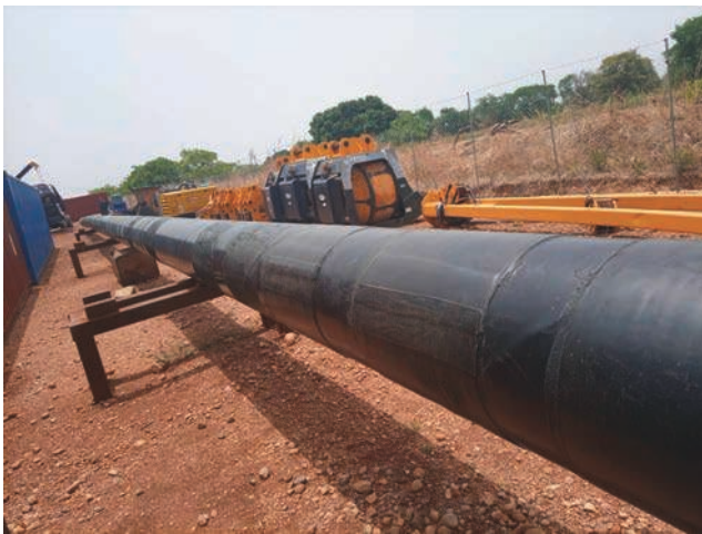
Fig. 4. Travaux de soudure de l'oléoduc à Gogounou.
