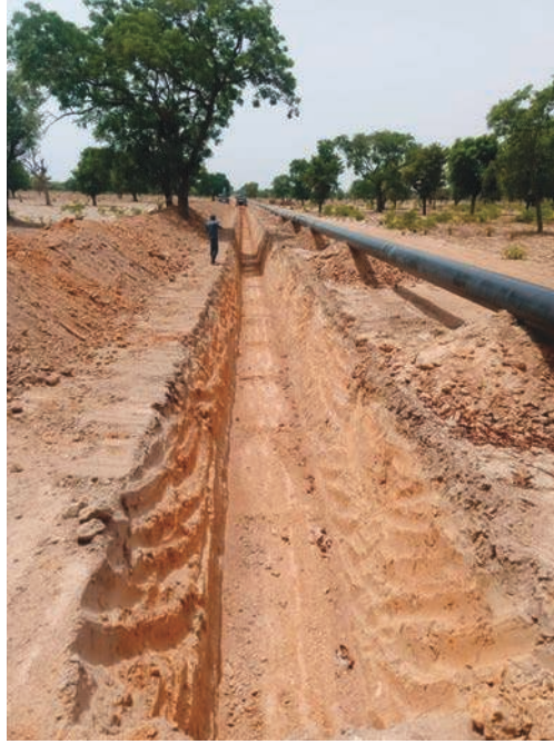
Fig. 5. Enfouissement de l'oléoduc à Gogounou.
